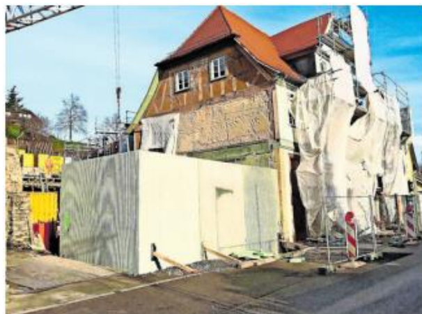
Noch ist das neue Hölderlin-Museum in Lauffen eine Baustelle Foto: Stadt Lauffen
